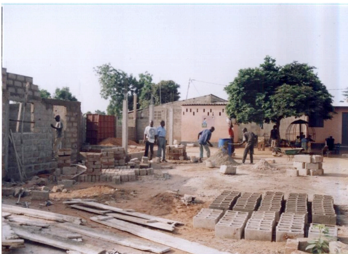
Lomè - I lavori proseguono...mattoni dopo mattoni
